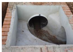
Figura 2 e 3 – Fundo das caixas de inspeção
